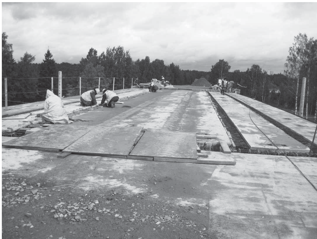
29.08.2011 года в 20.00 завершили укладку несущих балок нового путепровода на Горском шоссе
